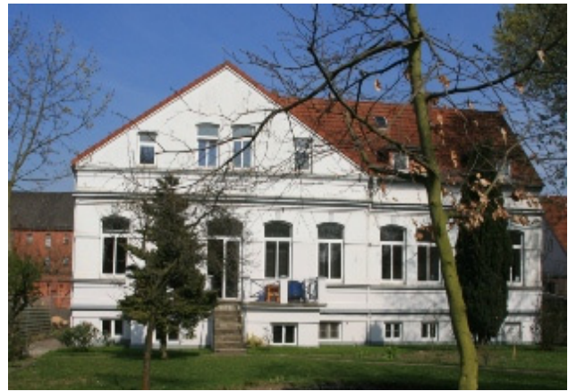
Das Gebäude des KompetenzCentrums.
