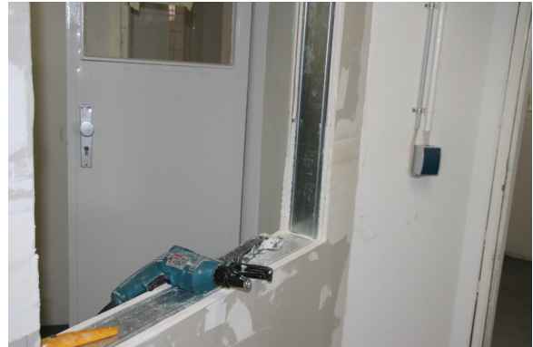
Renovierungsarbeiten in der JVA.
