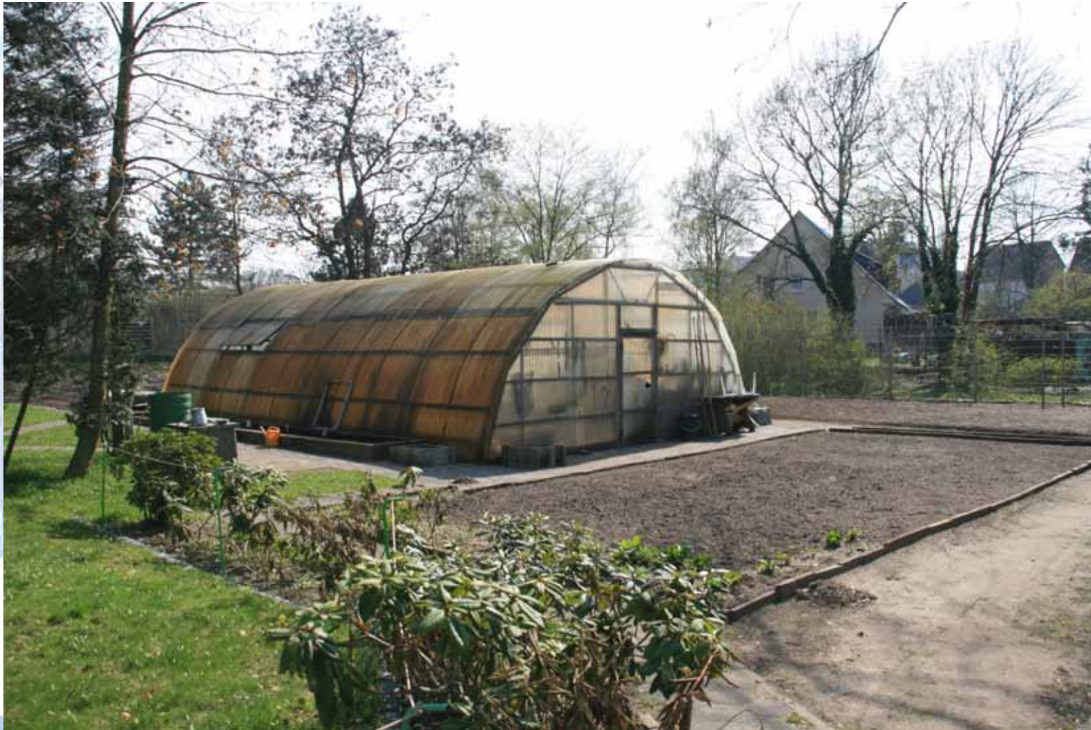
Renoviertes Gewächshaus, Nutzfläche für Anbau von Gemüse u.a.
