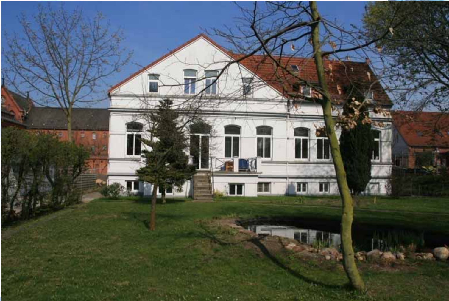
Rückfront KompetenzCentrum: Haus wurde von ehemaligen Strafgefangenen renoviert und hergerichtet
